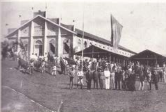
Prédio da Fábrica de Têxtil Machadense, já desativado, utilizado para a Semana Ruralista e Exposição Regional do Sul de Minas em 1937.
