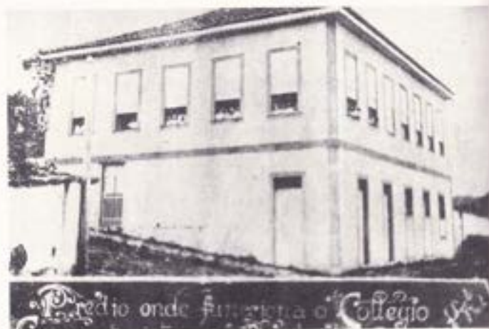
Primeiro prédio, na esquina das ruas Cel. Flávio e Santos Silva, onde instalaram-se as Irmãs Concepcionistas.
