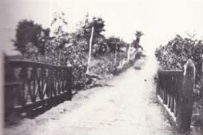
Ponte sobre o Ribeirão Jacutinga na Rua XV de Novembro.
