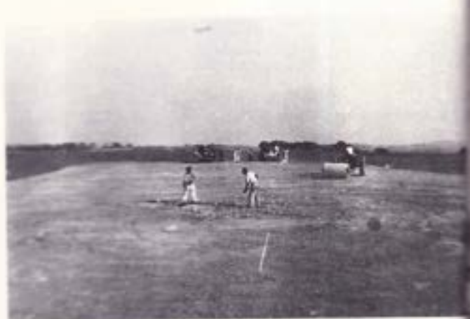
Obras da construção da pista do Aeroporto.
