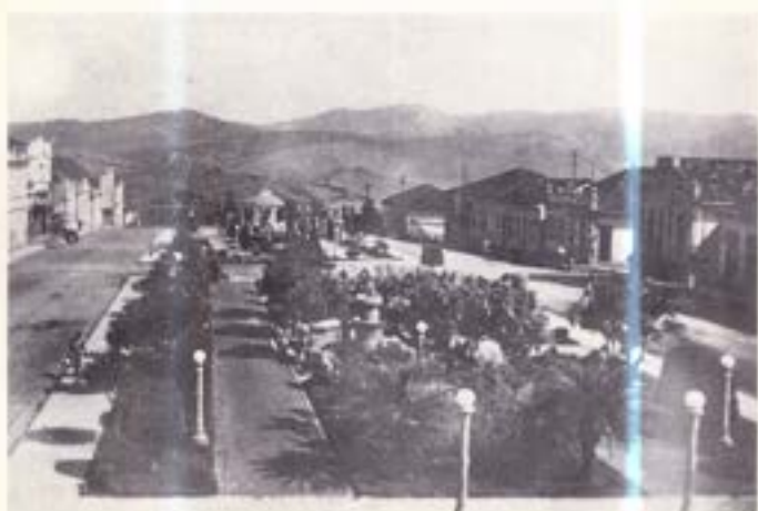
Praça Antônio Carlos, em 1945, mostrando a Fonte Luminosa recém-construída e as obras de calçamento ao redor.
