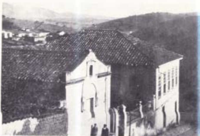
Primeiro prédio dos Irmãos Lassalistas em Machado na esquina das Ruas Cel. Flávio e Santos Silva.
