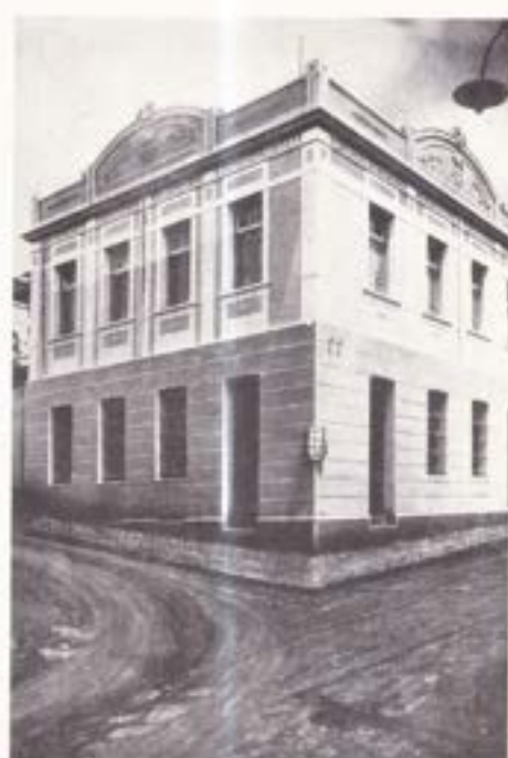
Prédio do Sr. Edgard Dias Swerts na esquina das Ruas Major Feliciano e Silviano Brandão. No piso inferior o Banco Hipotecário e Agrícola de Minas Gerais. No canto direito superior, detalhe mostrando o tipo de iluminação elétrica.
