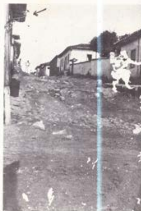
No canto esquerdo superior detalhe mostrando o lampião a gás acetileno fixo na parede de uma residência da Rua São Bento (atual Rua Santos Silva).
