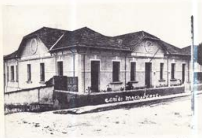
Centro Machadense após reforma do prédio
